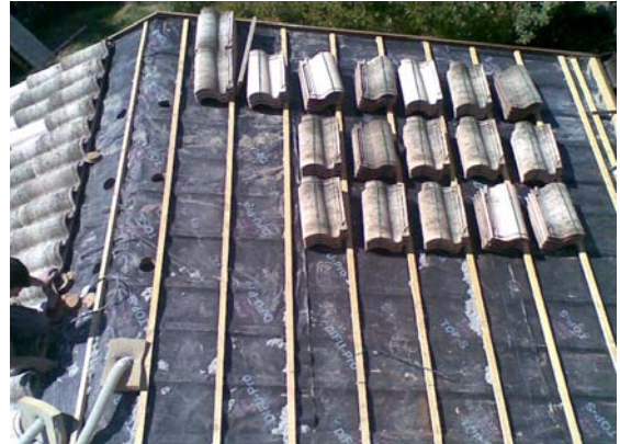
Ilustración 20. Trabajos de aislamiento en cubierta a base de celulosa proyectada. Fuente: http://www.aisleco.com/index.php?cual=aplica3
