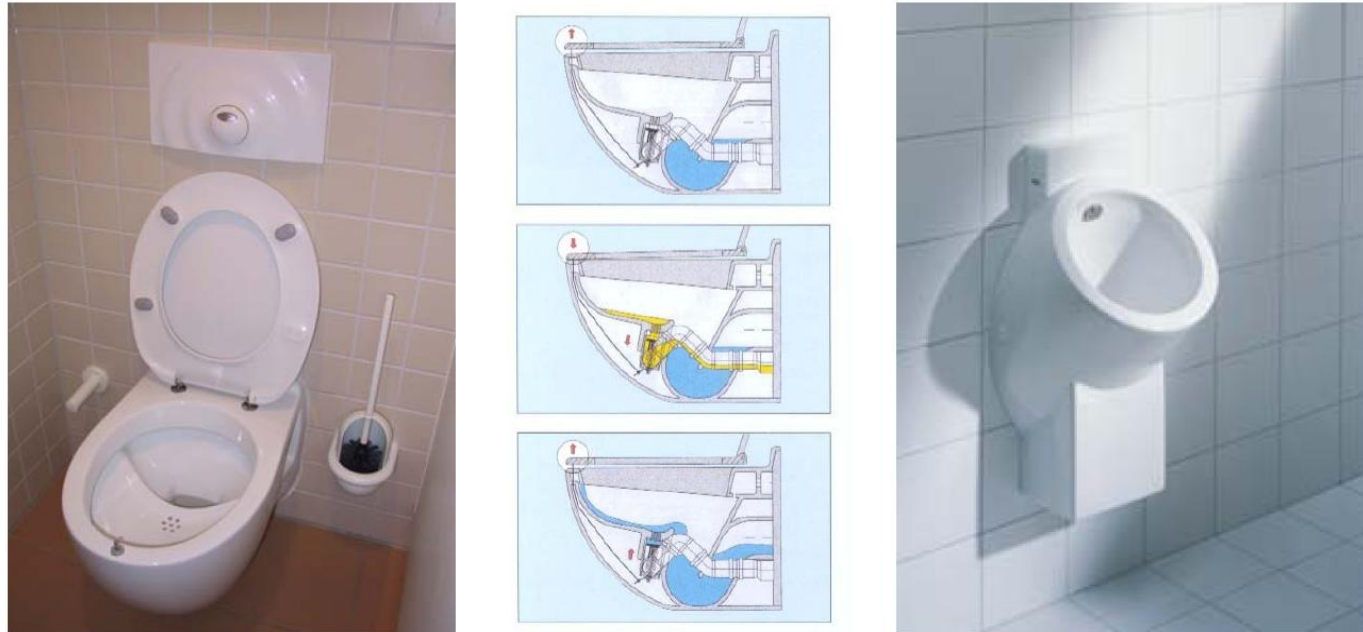
Equipamentos sanitarios de baixo consumo de auga e segregación de residuos en orixe para proxectos de saneamento ecolóxico (ECOSAN)
