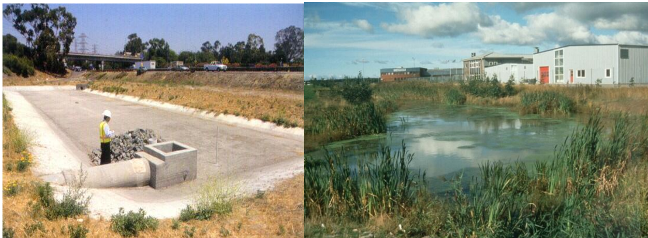
Estanque de retención integrado no contorno (cortesía de CALTRANS)
