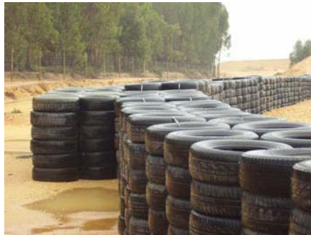
Figura 53 Neumáticos utilizados como barrera de circuitos. Fuente:
