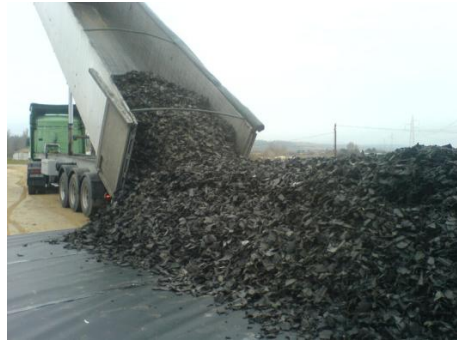
Figura 55 Restos de neumáticos usados como relleno de terraplenes.
