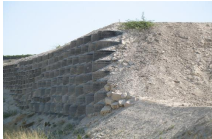
Figura 57 Muro creado con NFU. Fuente: SIGNUS
