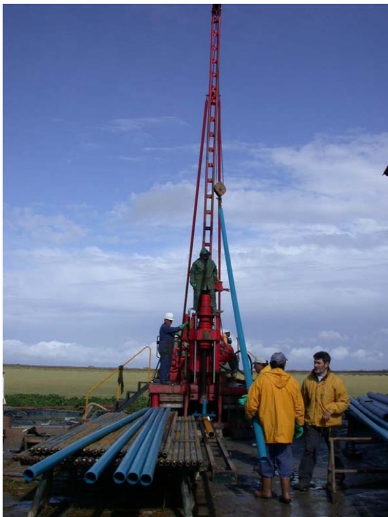
**Figura 2. Realización de un sondeo, mediante una máquina de perforación a rotación directa**
