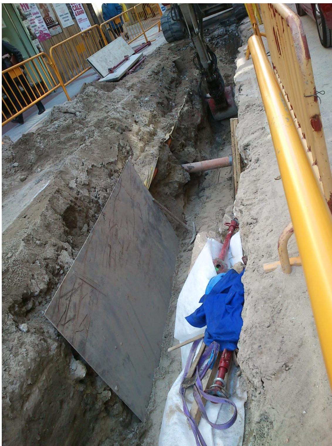
Figura 37. Entibado y apuntalamientos.
