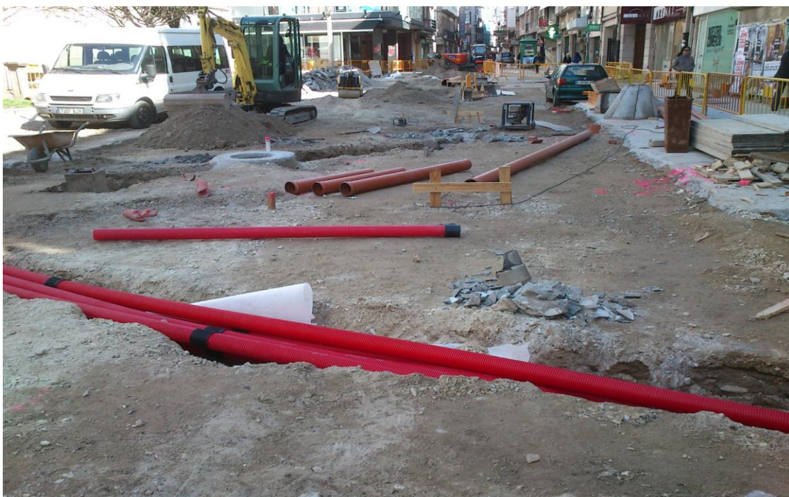
Figura 47. Colocación de elementos de la red de telefonía, televisión y telecomunicaciones.
