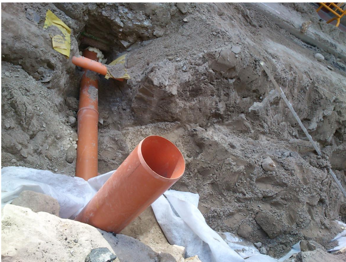
Figura 43. Relleno de la zanja
