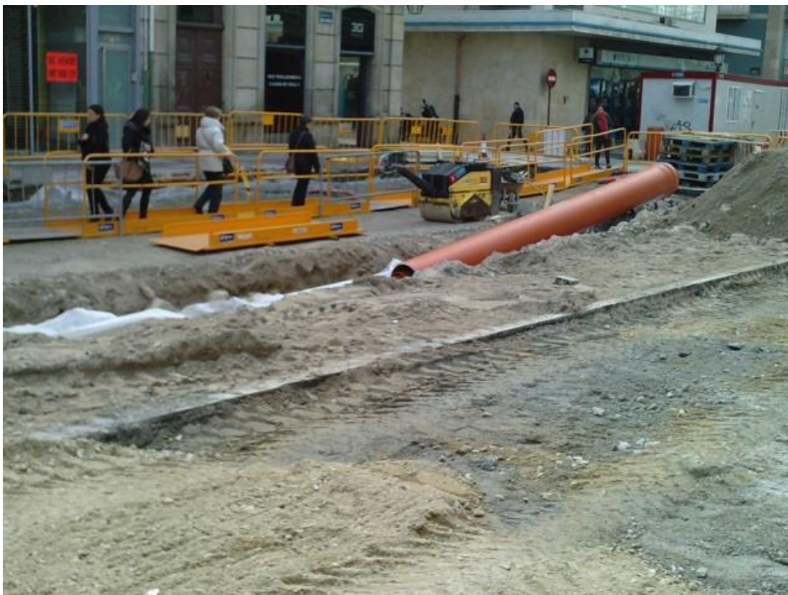
Figura 42. Colocación de las nuevas tuberías
