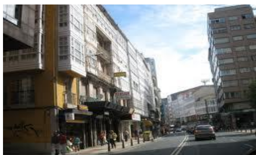
Figura nº1. Vista de la calle san Andrés, a pie de calle, antes de iniciar las obras.
