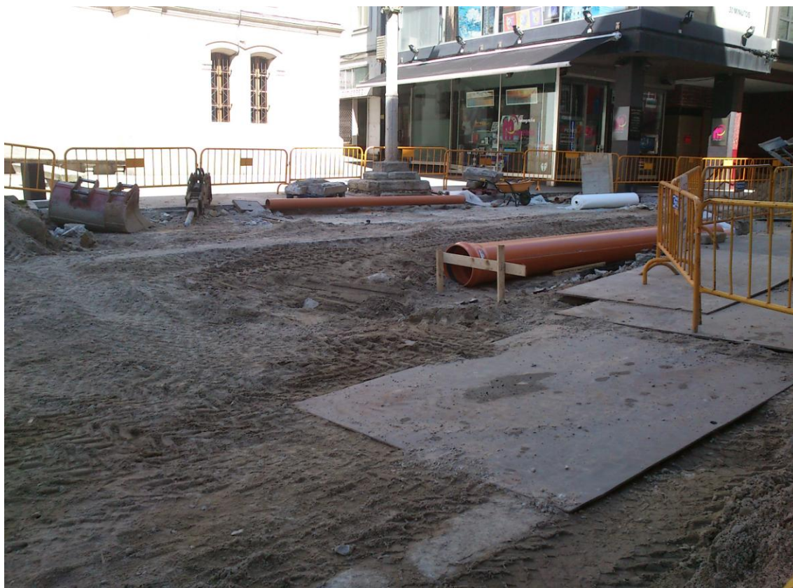
Figura 35. Demolición de los elementos presentes en la calle.
