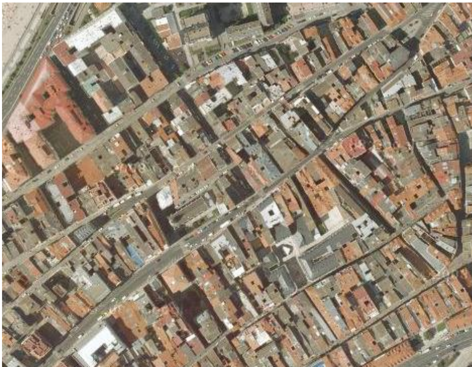
Figura nº2. Vista aérea de la calle de San Andrés
