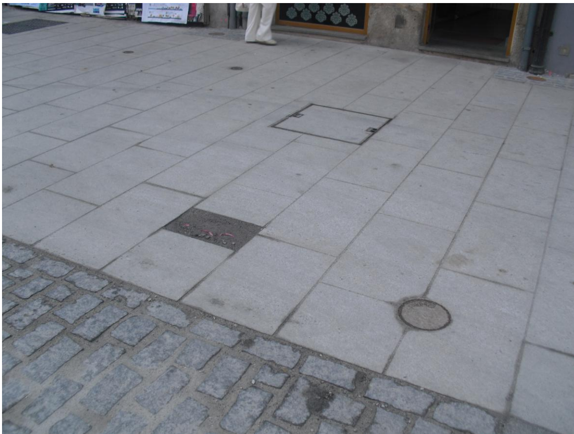
Figura 38. Aceras de pavimento ecológico con losas tipo ecoGranic.
