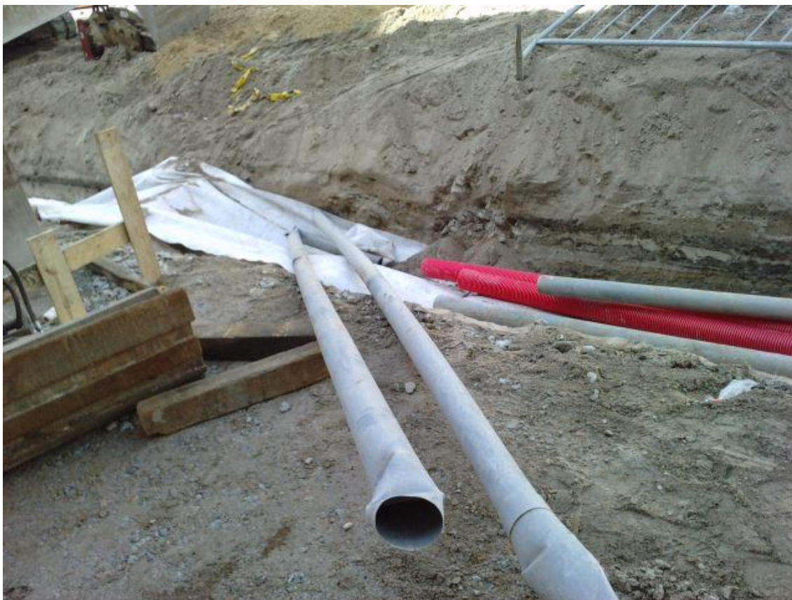
Figura 41. Sustitución de las tuberías ya existentes
